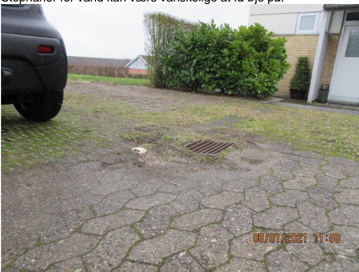
Belægning omkring rendestensbrønd sunket, så der er opkant. Desuden nogen græs-/ukrudtsvækst grundet jord omkring rist.
