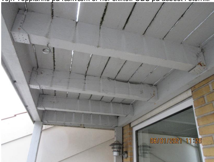
Altaner og disses konstruktioner generelt i rimelig stand. Bærende Bjælker og søjler kontrolleres løbende.
