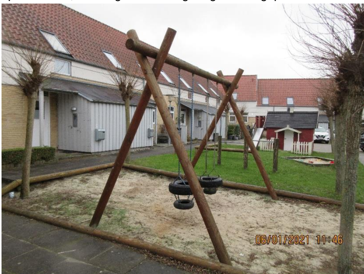
Gyngestativ i fin stand – dog bør faldsand renses for ukrudt og kontrolleres for tilstrækkeligt tykt lag.
