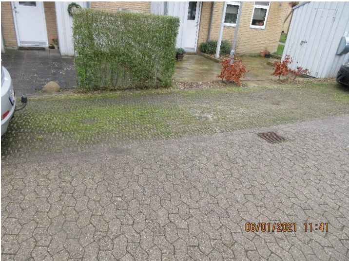
Forskellige flisebelægninger på fællesarealer – hér SF-sten og græsarmering.
