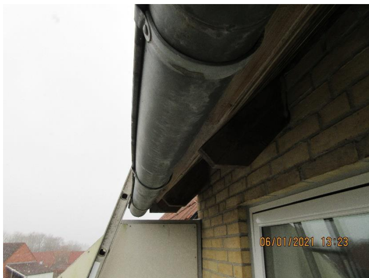
Tagrender er generelt i rimelig stand, om end lidt bulede og med bagfald nogle steder.
