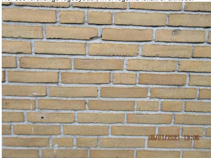
Der forekommer huller i fuger - særligt studsfuger - nogle steder. Huller bør udfyldes, men decideret omfugning bør ikke være nødvendig for nuværende.
