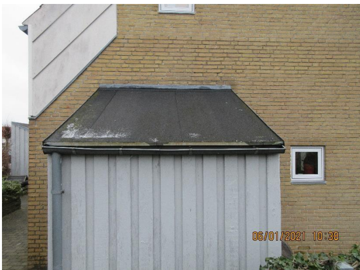
Tagbelægning med tagpap på skure. Generelt i rimelig stand. OBS på zinkinddækning mod mur, hvor gummifuger bør kontrolleres.
