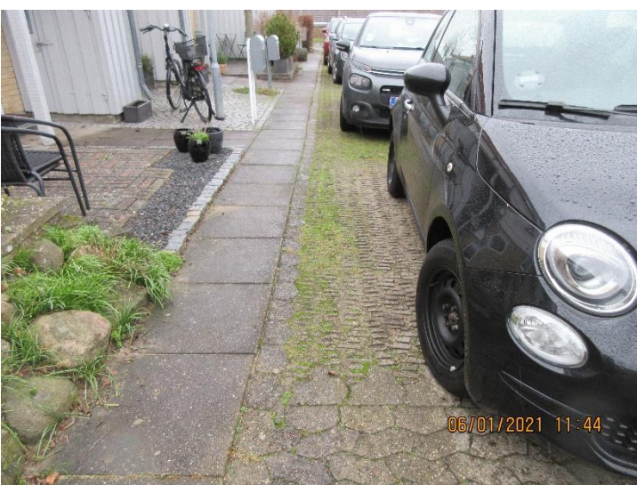
SF-sten, græsarmering og 60x60 cm betonfliser.
