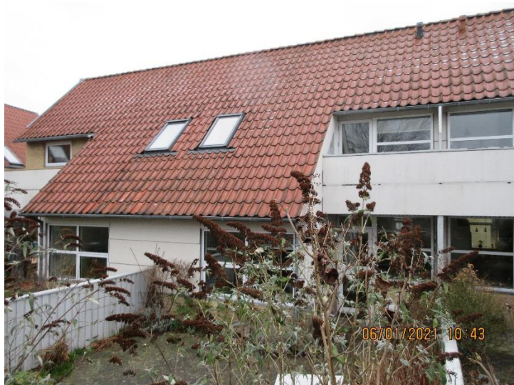
Tagbelægning af teglsten. Enkelte steder er sten afskallet / knækkede.
