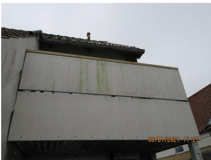
Algebelægning og skidt på eternitbeklædning - altan.
