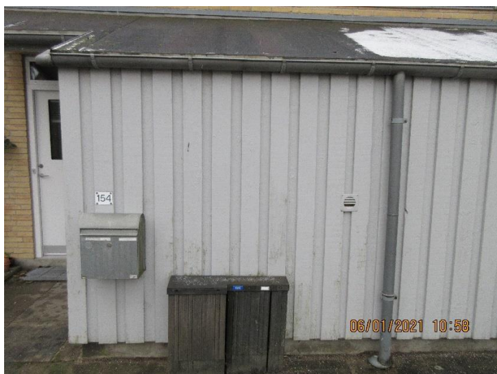
Tagrender / nedløb generelt i rimelig stand. Dog ses bagfald på nogle tagrender – særligt på træskure. Desuden enkelte buler.
