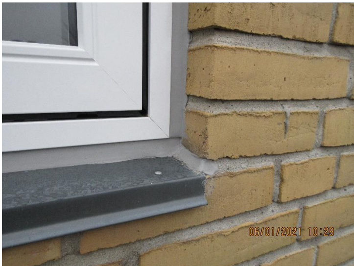
Inddækninger i zink – her som sålbænk ved lille vindue. Elastiske fuger skiftet ifm. vinduesudskiftning i 2020.
