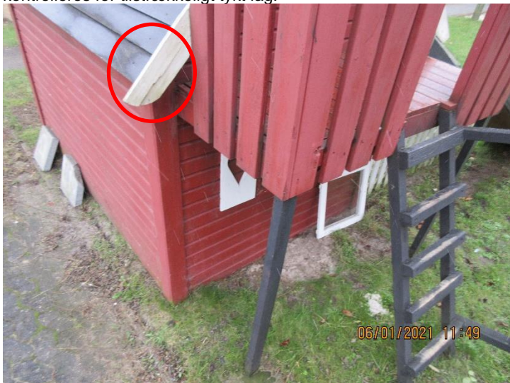
Vindskede på legehus er revnet. Lægter, der bærer platform til rutsjebane, virker lidt kleine i det.
