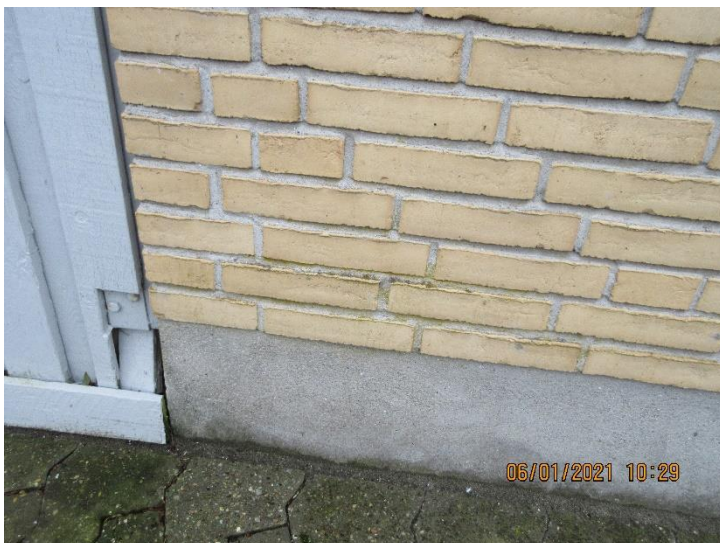
Lidt alge/mos-vækst nogle steder på murværk og mørtelfuger.
