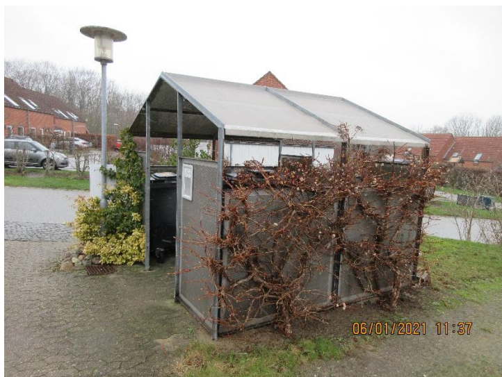
Afskærmet og overdækket affaldsplads. Perforerede stålplader på skelet af galvaniseret stål.
