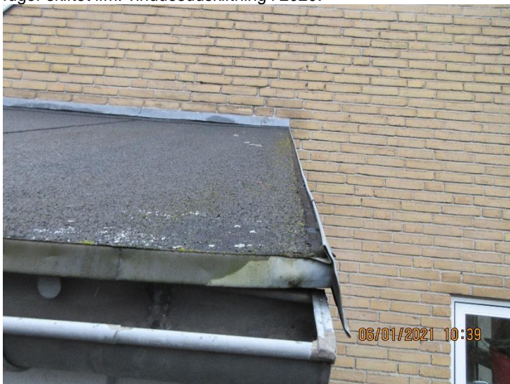
Zinkinddækninger vurderes generelt at være i rimelig stand. Særligt indskud i murværk bør have kontrolleret den elastiske fuge.
