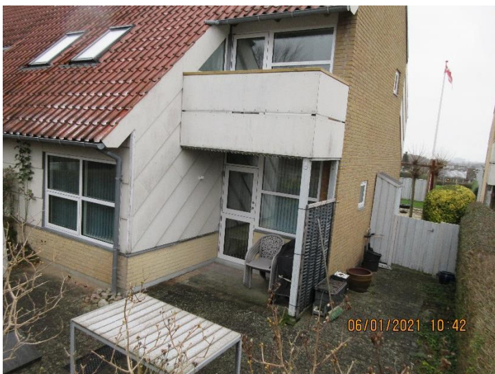
Døre og vinduer skiftet i 2020 – Ovenlys dog i 2013.
