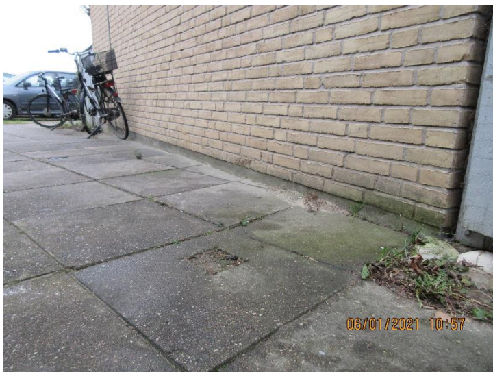
Sokkel er ikke mindst 150 mm høj. Hvor flisebelægninger er ført helt ind mod sokkel, kan opstrøjt give øget algevækst på såvel sokkel som de nederste mursten. Særligt mod nord.
