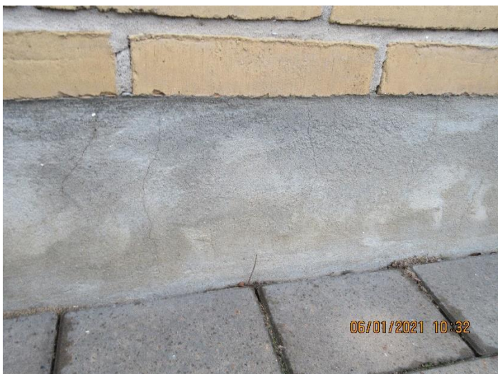
Svindrevner i sokkelpuds ses flere steder.
