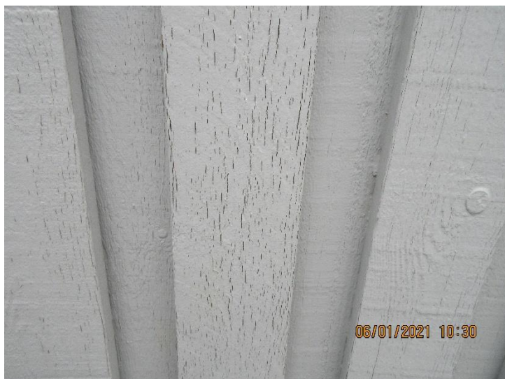
Træværk trænger generelt til maling – her ses udtørret og revnet maling på plankeværk mellem haver.
