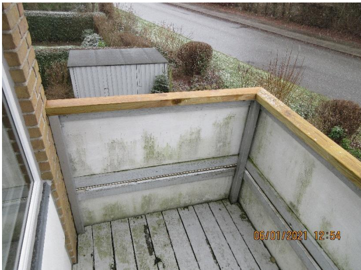
Træbelægning på altaner er relativt hårdt påvirket af slid, vind og vejr. Topplanke på rækværk er her skiftet. OBS på asbest i eternit.
