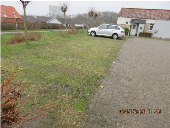
Græsarmering og SF-sten ved parkeringsplads.
