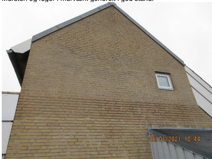
Partielt er der dog forskel på fugerne i både stand og udførsel. Her ses forskellige fugedybder, hvor fugerne lokalt er skiftede.
