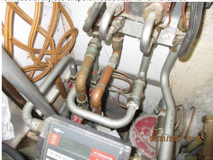
Vand- og varmeinstallationer – lidt ir i samlinger og overfladerust på tilslutninger til vekslerflade. Bør holdes under opsyn.
