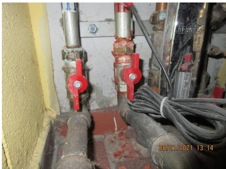
Irrede samlinger på varme frem og retur. Den røde farve på "frem" formodes at skyldes et sporemiddel, tilsat fra varmegæret.
