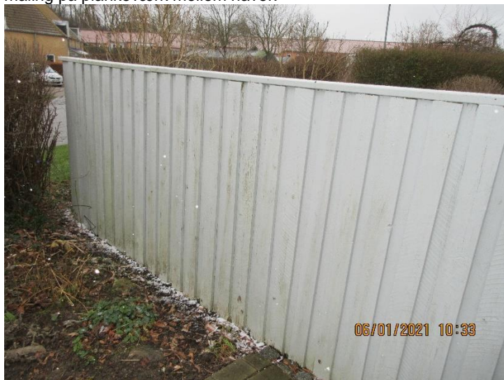
Plankeværk mellem haver – bunden støder helt ned til terræn med øget opfugtning til følge – der er råd i bunden af beklædningen.
