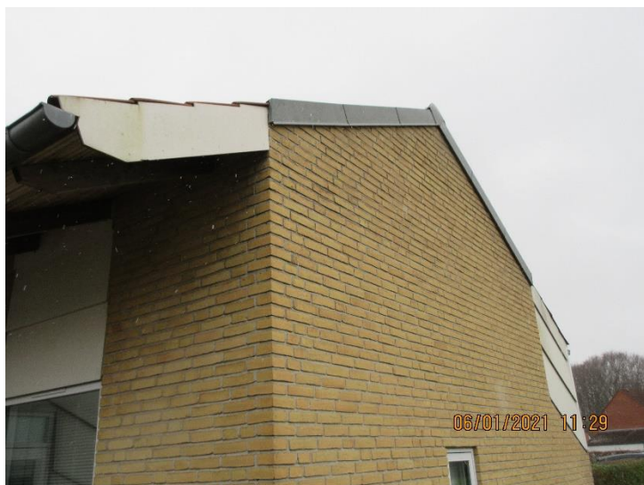
Mursten og fuger i murværk generelt i god stand.
