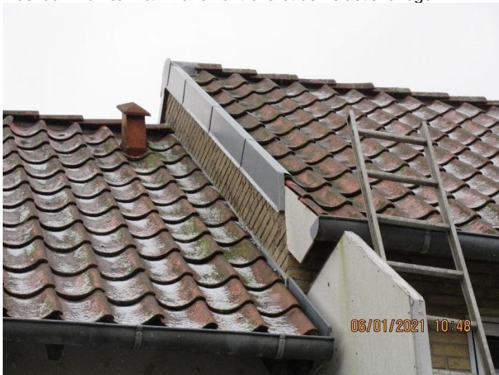
Vindskeideinddækninger af nyere årgang. Vurderes af være i rimelig stand, men bør vurderes nærmere ifm. evt. tagudskiftning. Det er ikke sikkert de kan genbruges.
