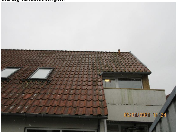
Der ses algevækst på tagflader og eternitbeklædninger flere steder – især på skyggefulde placeringer. Det har umiddelbart ingen konstruktiv betydning, men kommer der decideret mos, kan en stor mængde løfte stenene, så der kan komme vandindtrængen.
