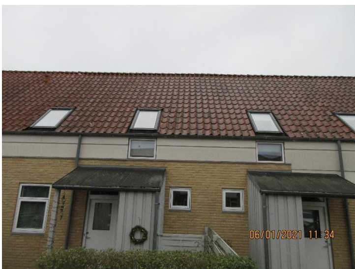
Døre og vinduer skiftet i 2020 – Ovenlys og underparti dog i 2013. Alle elastiske fuger er skiftet sammen med døre og vinduer.
