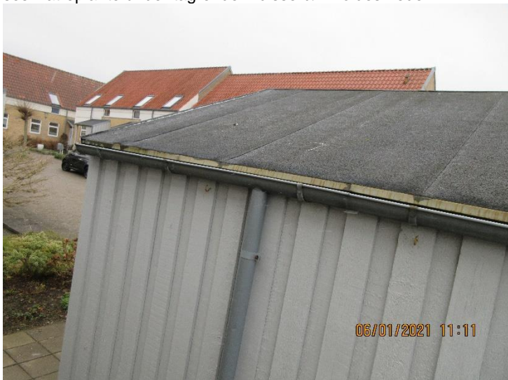
Tagbelægning med tagpap på skure. Generelt i rimelig stand. Der ses mindre bagfald på tagrender nogle steder.
