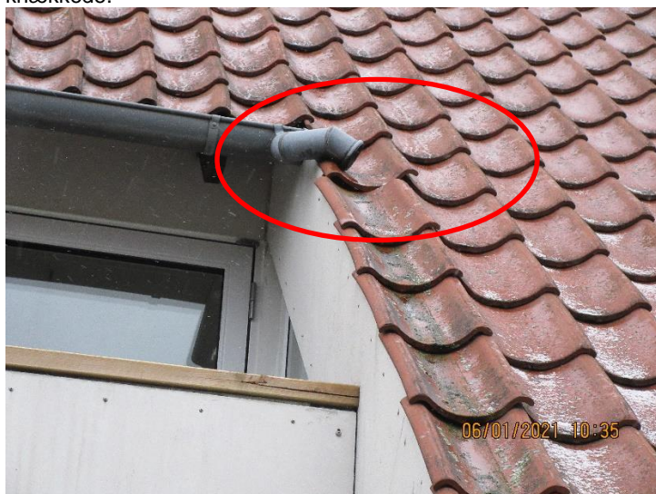
Tagsten har ikke korrekt overlæg over nedenliggende sten. Kan give uønsket vandindtrængen.
