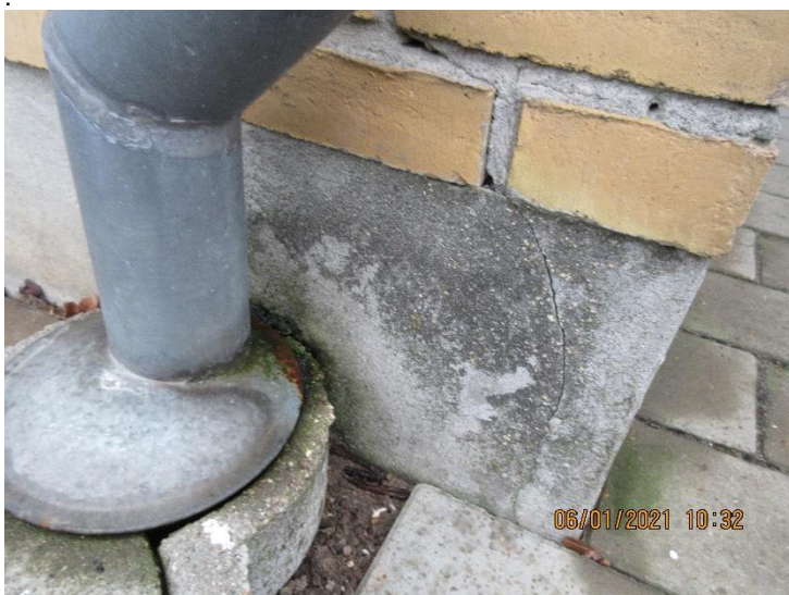
Revner i murværk lokalt – her en formodet mindre forskydning i Hjørne i både stenfuge og sokkel/sokkelpuds.
