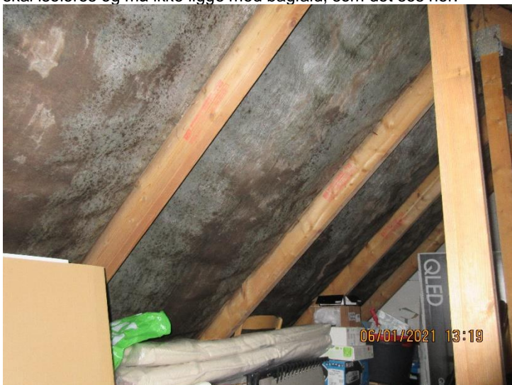
Undertag er generelt temmelig "sprødt" og har her skimmel-lignende Plamager. Desuden fornemmes begyndende huller / stort slid, hvor undertaget ifm. blæst, slår mod bagsiden af tagsten (nakken).
