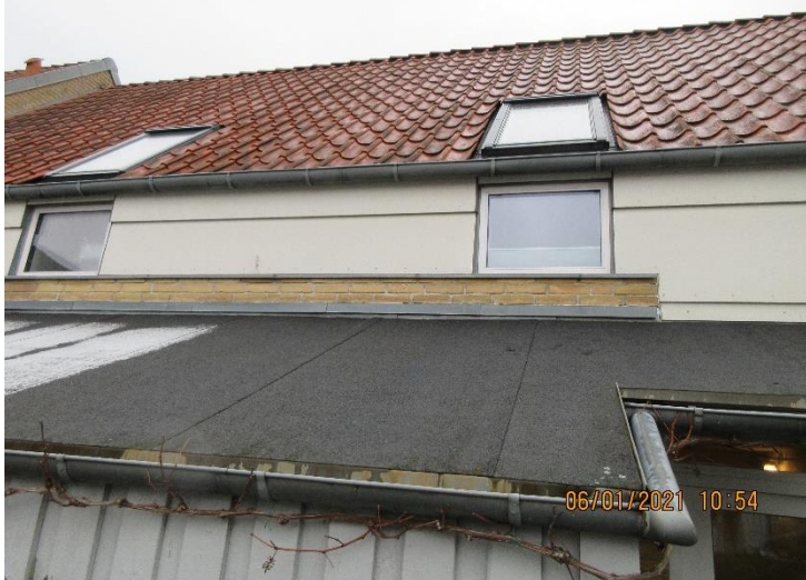
Tagbelægning med tagpap på skure. Generelt i rimelig stand. Her ses klatreplante under tagrende – disse bør holdes nede.
