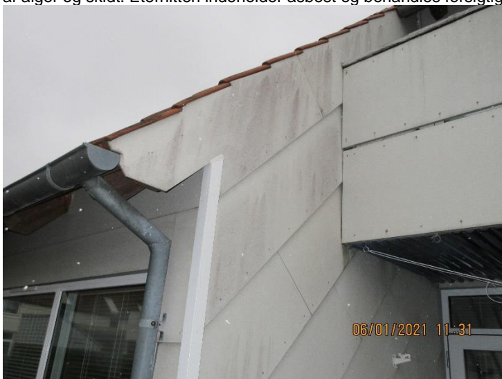
Algebelægning og skidt på eternitbeklædning – klimaskærm.
