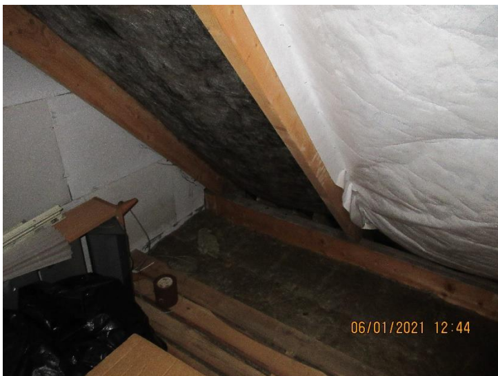
Undertag er generelt i mindre god forfatning. Her ses nødtørfig reparation - Den hvide dug er uhensigtsmæssigt fastgjort på spærsider.
