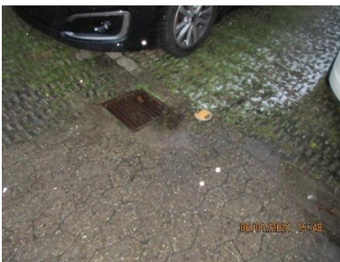
Belægning omkring rendestensbrønd sunket, så der er opkant. Stophaner for vand kan være vanskelige at få øje på.
