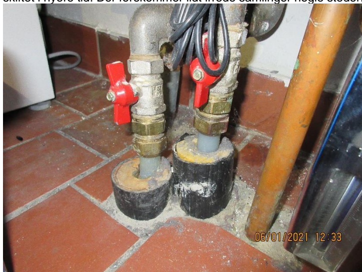
Varmeinstallationer – varmeslanger i isolerede opføringsrør og stophaner.
