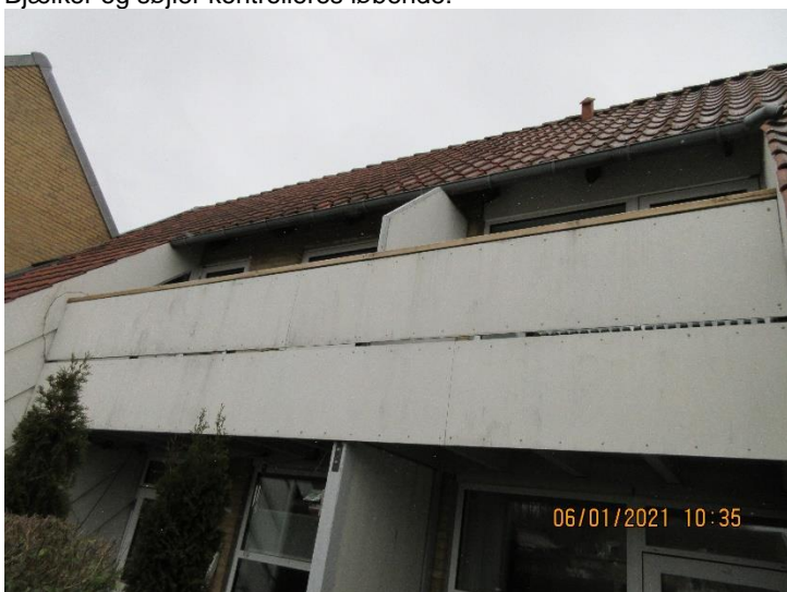
Eternitbeklædning på altaner. Indeholder asbest, så evt. afrensning skal foretages forsigtigt.
