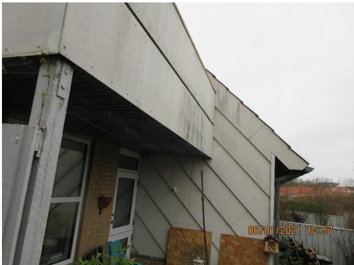
Eternitbeklædning på både altaner og klimaskærm har belægninger af alger og skidt. Eternitten indeholder asbest og behandles forsigtigt.
