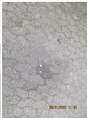
Belægning omkring rendestensbrønd sunket, så der er opkant. Stophaner for vand kan være vanskelige at få øje på.
