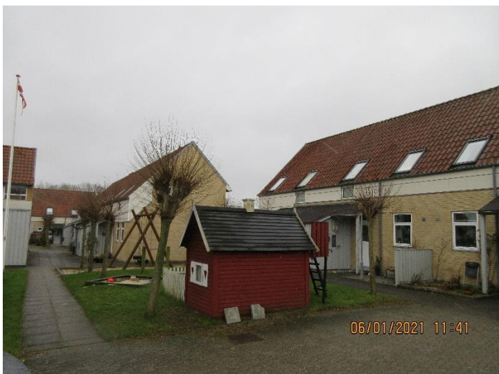
Legeplads i rimelig stand – dog nogle punkter til opfølgning. NB! Der bør laves aftale om eftersyn/udbedring med firma med speciale heri, da der gælder særlige regler for legepladser.
