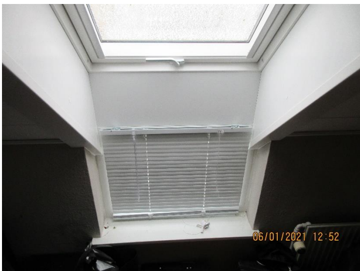
Ovenlysvindue og underparti set indefra – begge dele skiftet i 2013.
