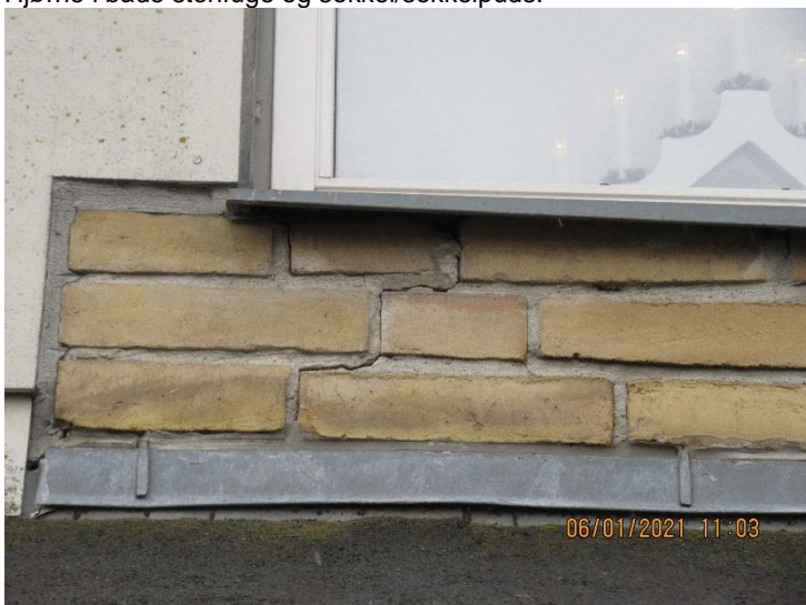
Revne i fuger i murværk mellem tag på skur og vindue på værelse. Elastiske fuger generelt mellem murværk og tilstødende bygningsdele (her eternit) er i mindre god stand og bør skiftes.
