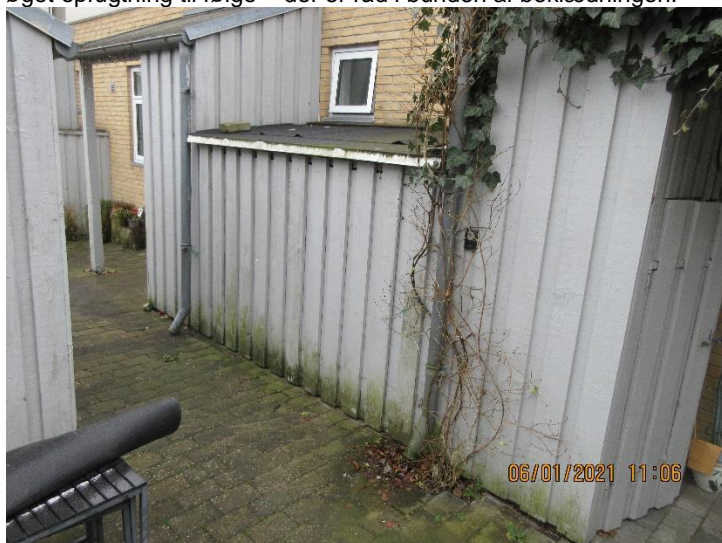
Træværk på skure mod nord går helt til terræn. Derfor øget opfugtning, algevækst og risiko for råd. Klatreplanter bør holdes i ave.
